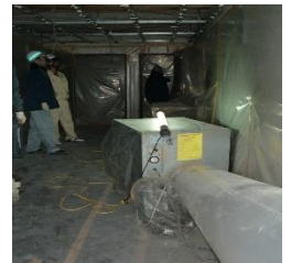
隔離養生区画内(除去作業前)
